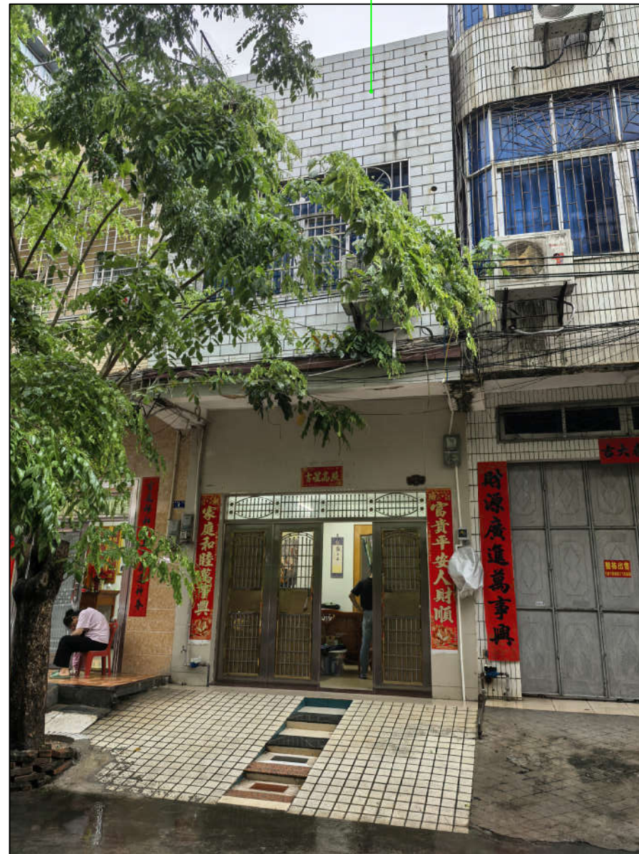
项目所在地 拆除原有二层建筑
