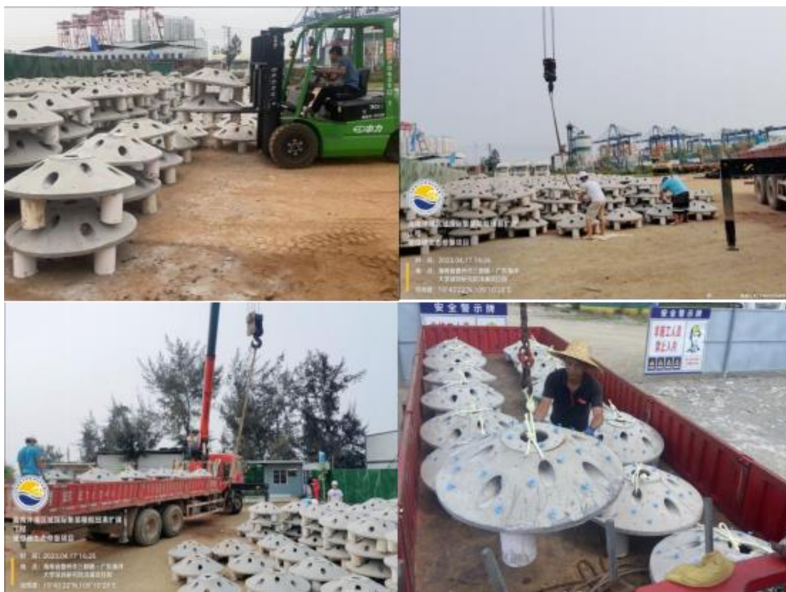
图 2.3.3-2 人工珊瑚礁礁体吊装
