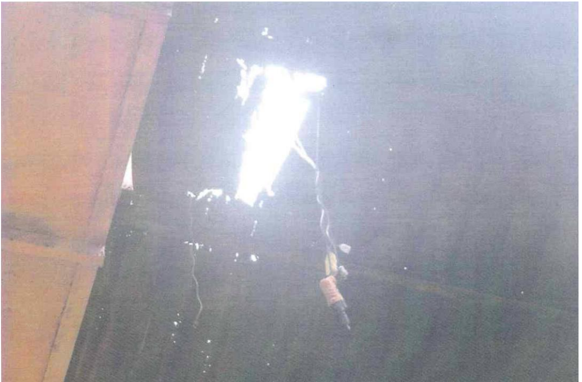
图 2 中心现场局部概览照片
