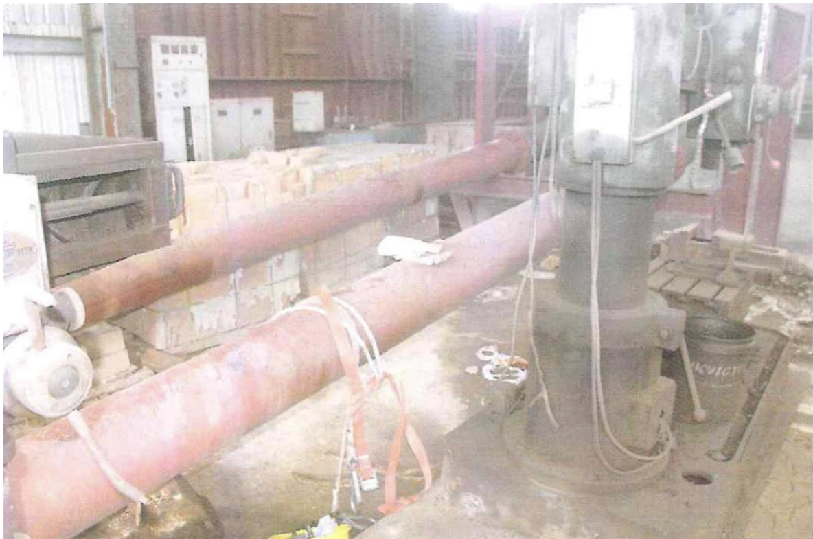
图3 中心现场局部概览照片
