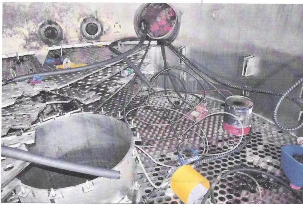
事发1效B罐内部现场图（由西往东方向拍摄）
